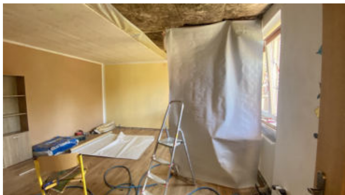
Maľovanie centra a zateplenie stropu
